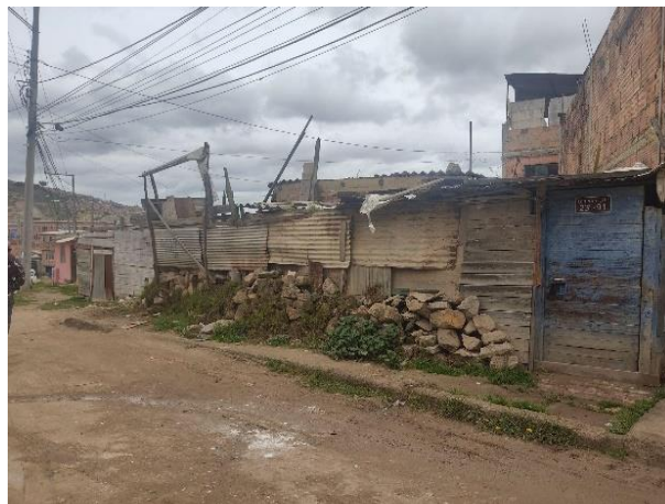
Viviendas construidas en tejas de zinc
